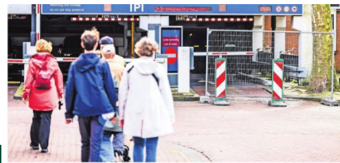
A De parkeergarage aan de Spuihaven is gesloten in verband met scheuren in het beton. FOTO: JEROEN DE VRIES
