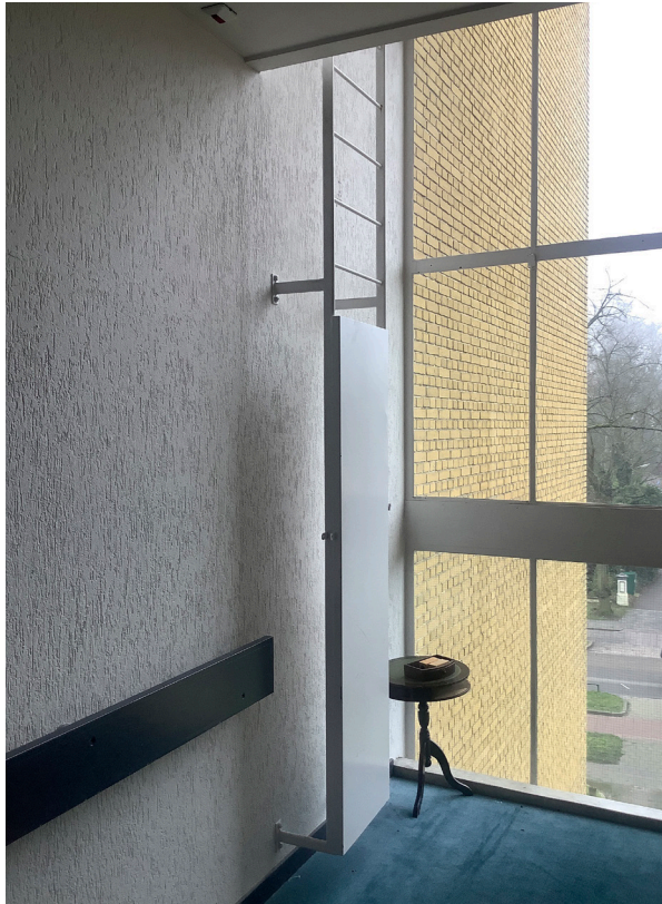
Verticale glazen pui tussen studioruimtes waar oorspronkelijk de trappen hebben gezeten.
