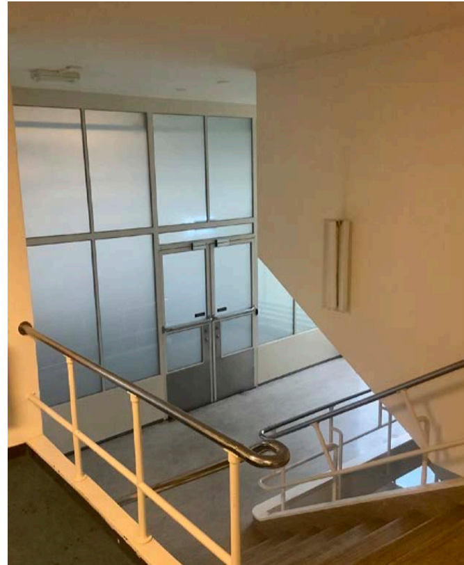
bordes centraal trappenhuis met rechts de later toegevoegde technische ruimte en dichtgeplakte glazen tussenwand.
