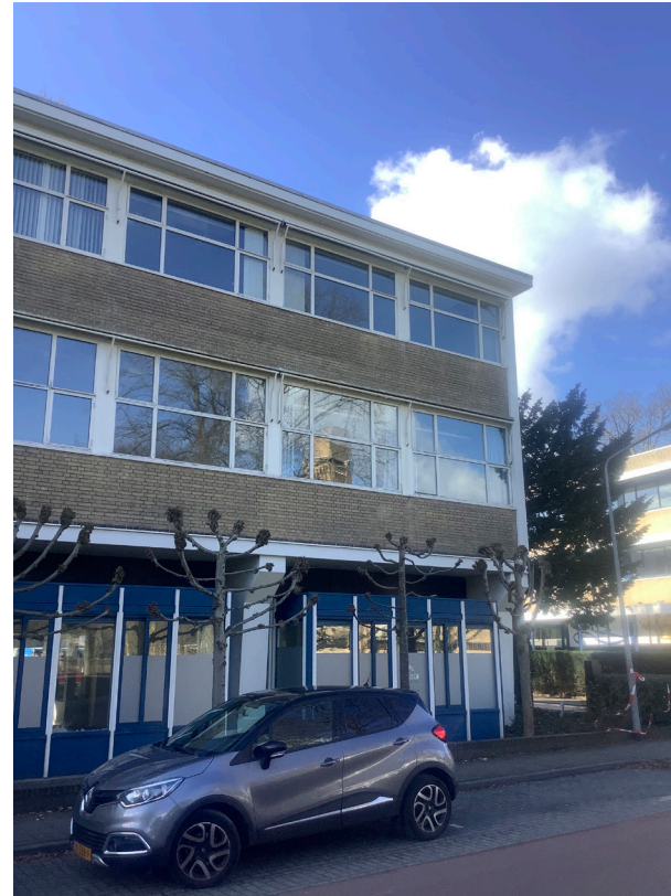
inbouw onder poortgebouw.
