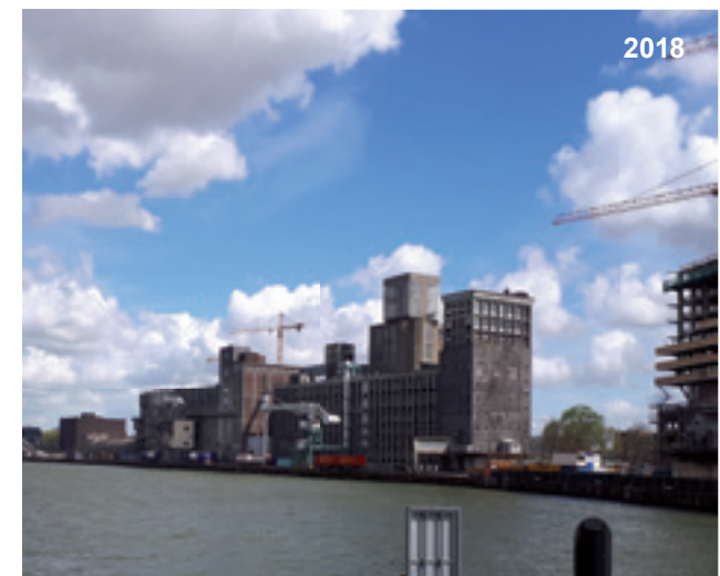
Codrigo gezien vanaf het noordwesten
