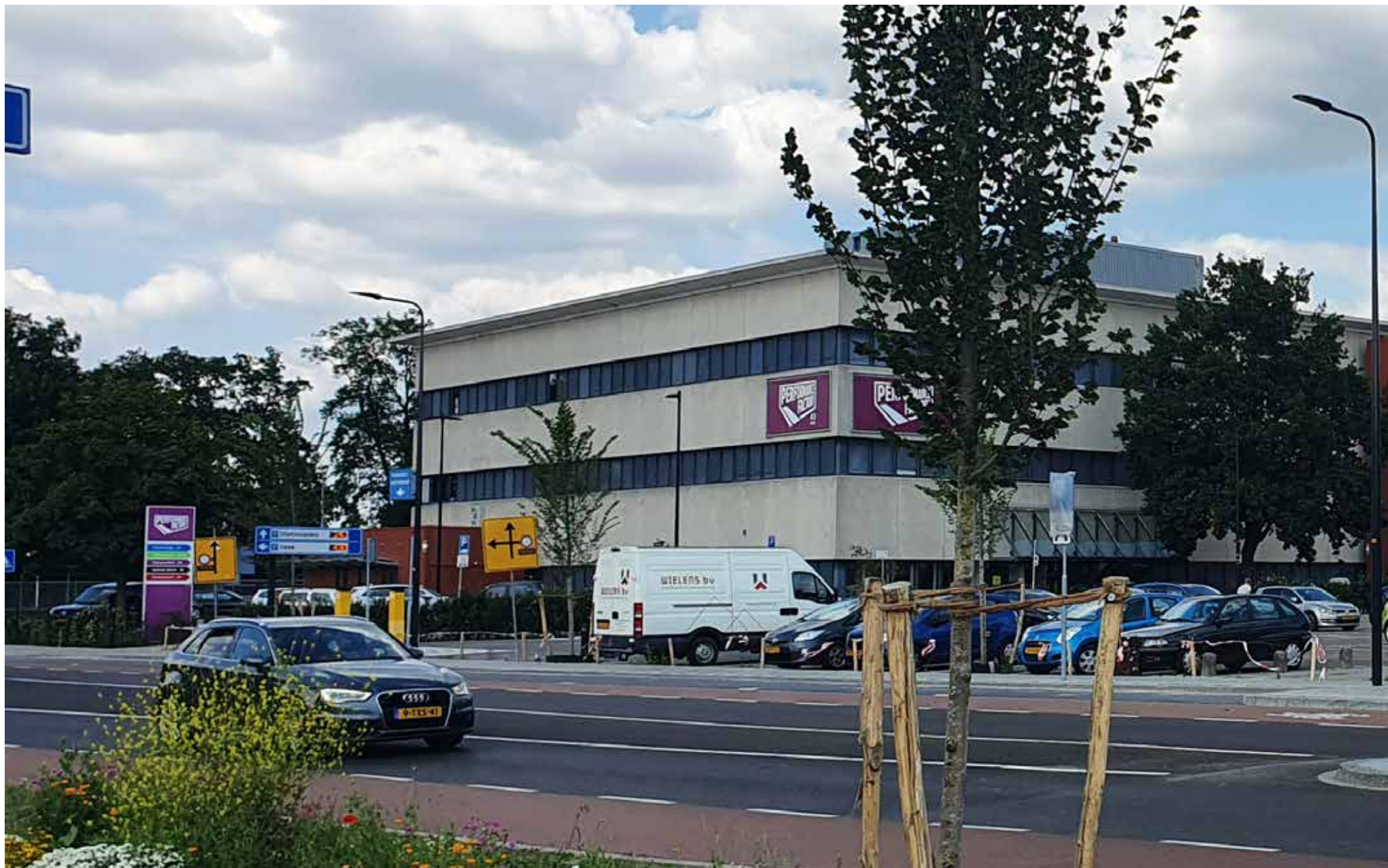
Huidige situatie hoek Oldenzaalsestraat - Hoge Bothofstraat
