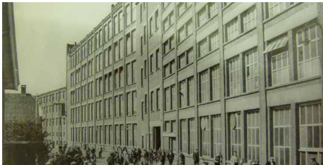
Afb. 27 Historische functioneel gedetailleerde fabrieksgevels met op slechts enkele plekken een rijk gedecoreerde dakranden, plastische opbouw van horizontale en verticale structuur waarbij de verticale structuur de overhand heeft.
