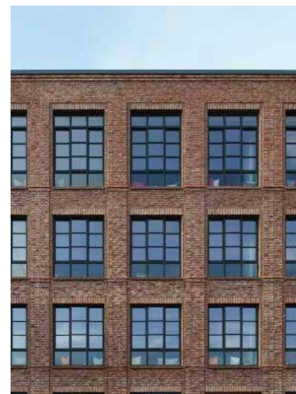
Afb. 29 functioneel gedetailleerde 'fabrieksgevel'
