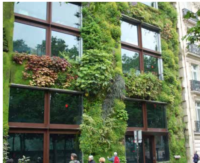
Afb. 37 Groen gevels vanuit de binnentuin
