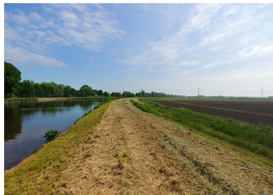
17 zicht op het Winschoterdiep vanaf de kanaaldijk
