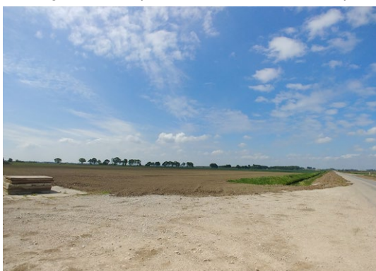
18 toegangspad windturbine in aanbouw
