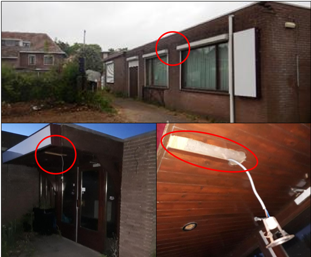
Afb. 3.1.1. Locaties van twee zomerverblijfplaats van gewone dwergvleermuis in de westgevel van de voormalige horecagelegenheid.
