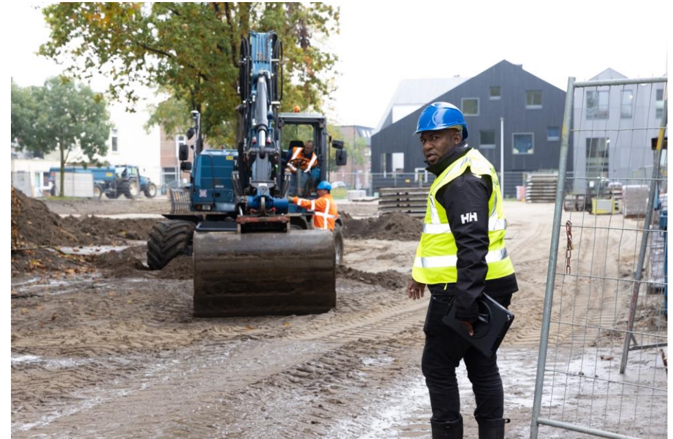
Bouwplaats 2e Daalsedijk
