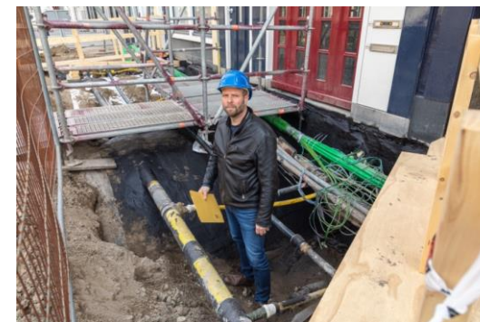
Bouwplaatsinspectie in stadscentrum
