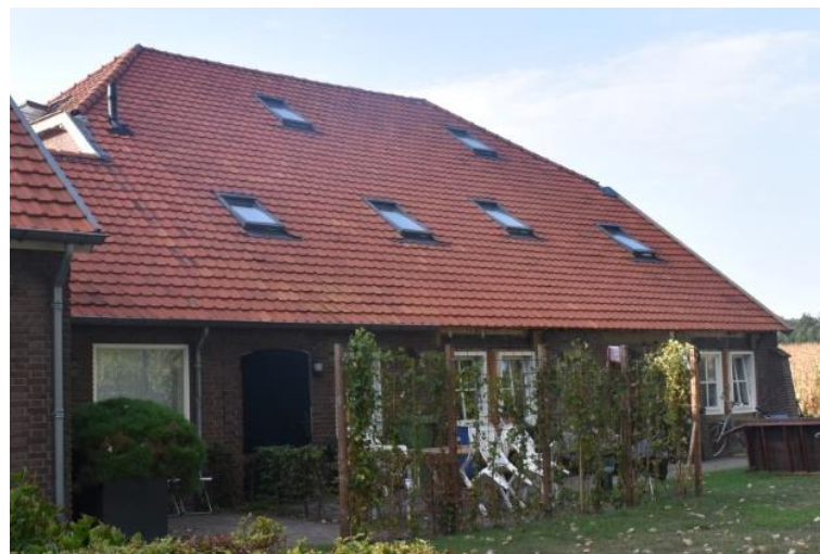
Voorgevel van het bedrijfs gedeelte.
