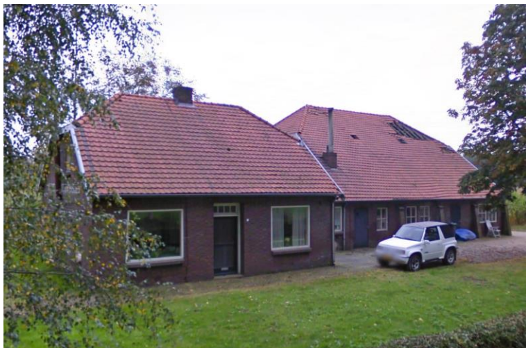
Foto van de voorgevel en linkerzijgevel van de Liempdseweg 51 te Sint-Oedenrode uit 2009. Bron: Google Maps.
