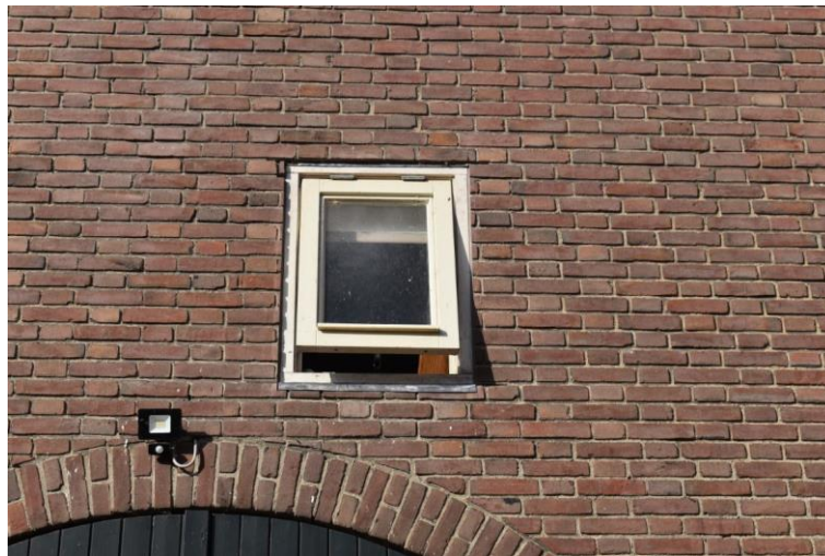
Linkerzijgevel van de verdieping van het bedrijfsgedeelte.
