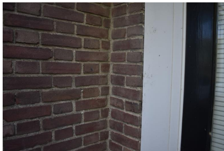
Overgang metselwerk rechterzijgevel woongedeelte (links) en voorgevel tussenlid (rechts).
