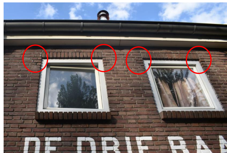
Verdieping linkerzijgevel woongedeelte. Rood omcirkeld de bouwsporen in het metselwerk.
