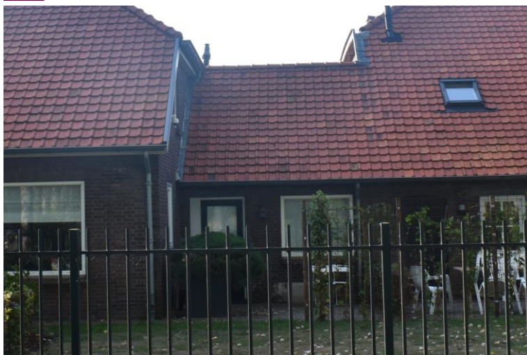
Voorgevel van het tussenlid met links het woongedeelte en rechts het bedrijfs gedeelte.
