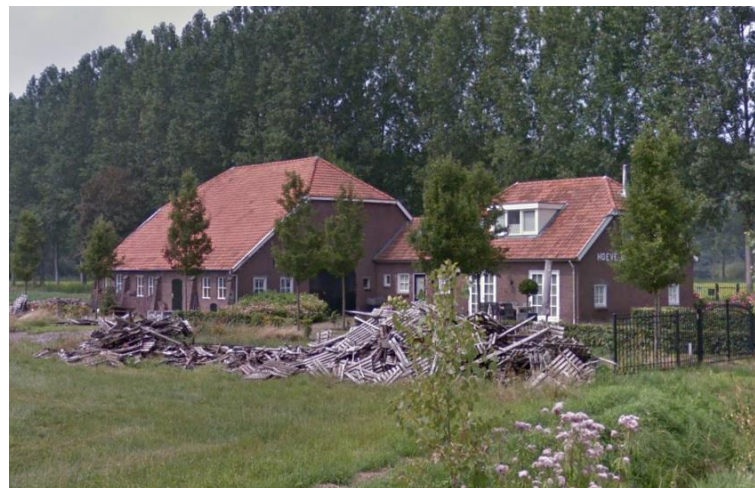
Foto van de achtergevel van de Liempdseweg 51 te Sint-Oedenrode uit 2016. Bron: Google Maps.
