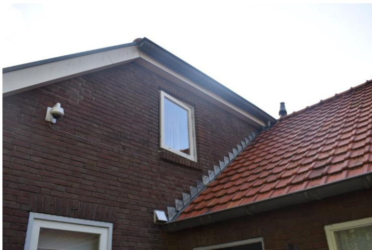
Rechterzijgevel woongedeelte met venster op de verdieping.
