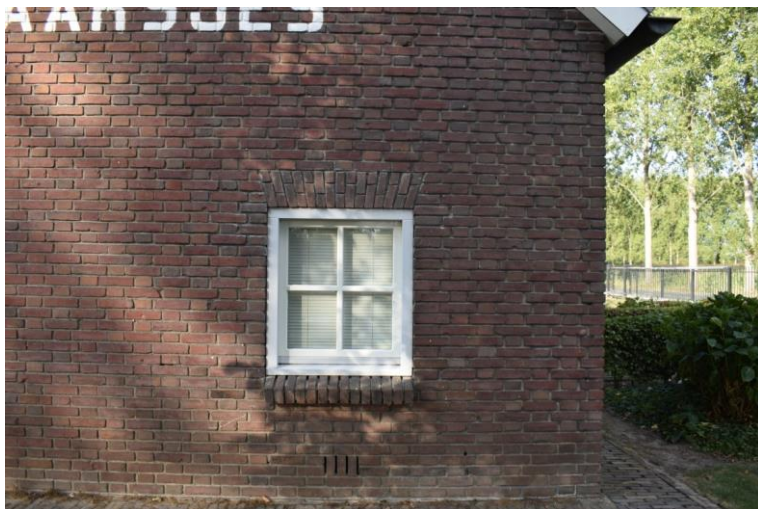
Linkerzijgevel met vernieuwd houten vierruits venster.
