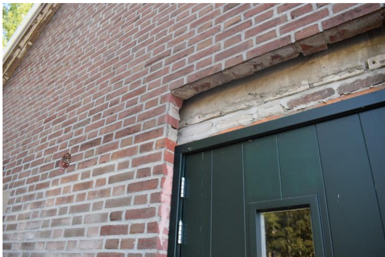
De opening is vergroot door de opening uit de gevel te zagen.
