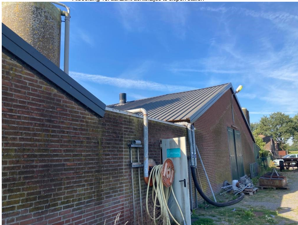
• Afbeelding 16: aanzicht achterzijde te slopen stallen
