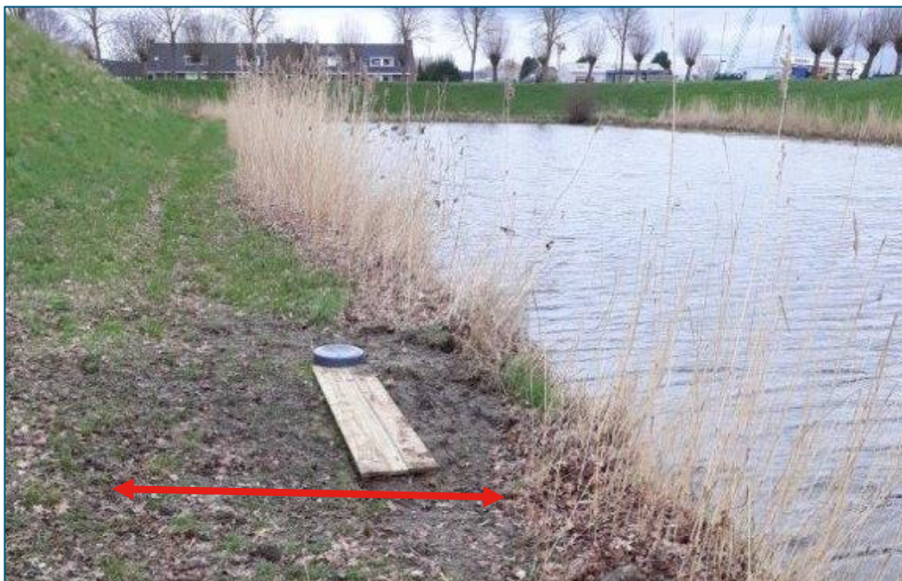
Figuur 3-8: Vlak gedeelte onderaan het talud zorgt voor invangen van afspoelend materiaal.
