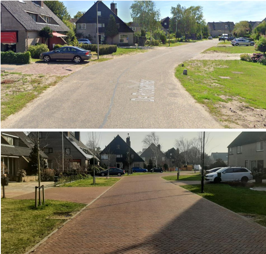
Figuur 5.2: herinrichting Rookamer van asfalt naar gebakken elementenverharding
