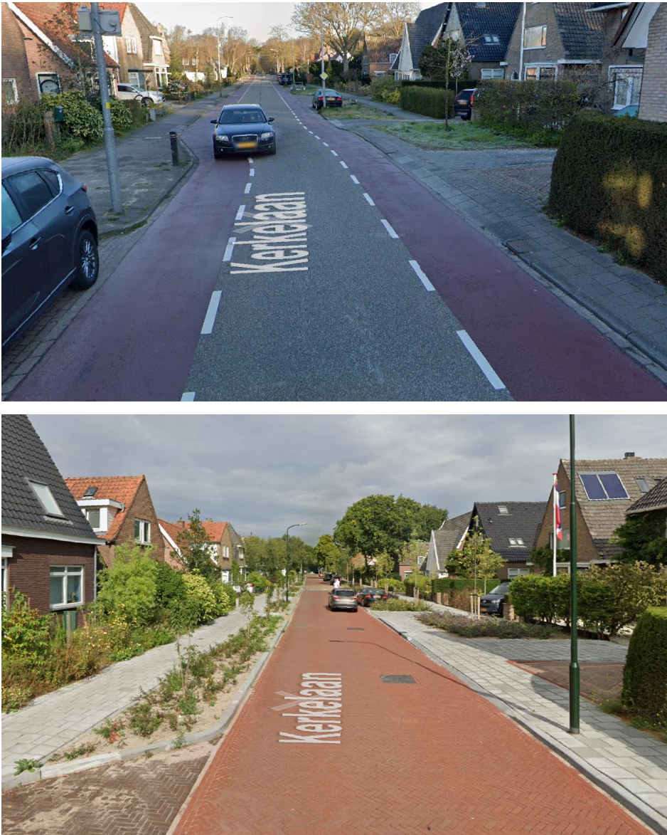
Figuur 5.3: reconstructie Kerkelaan van asfalt naar elementenverhardingen.
