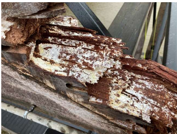
Ernstige witrot in de balanspriem op een groot aantal locaties.
