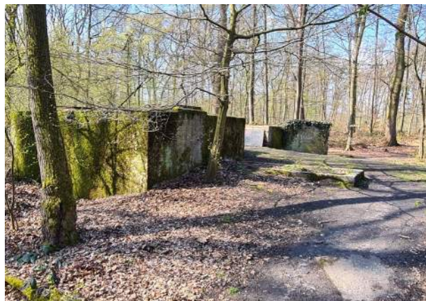
De pompputten liggen als follies verspreid over het noordelijk deel van het Schutterspark.
