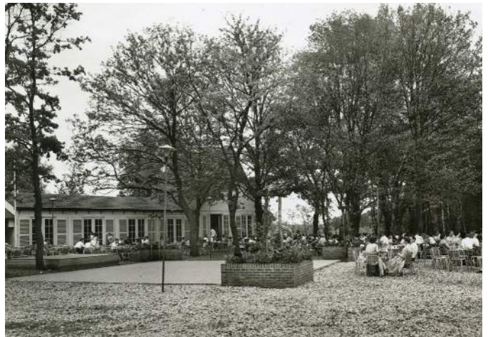
Het gerenoveerde Schuttershúske met nieuwe dansvloer.
