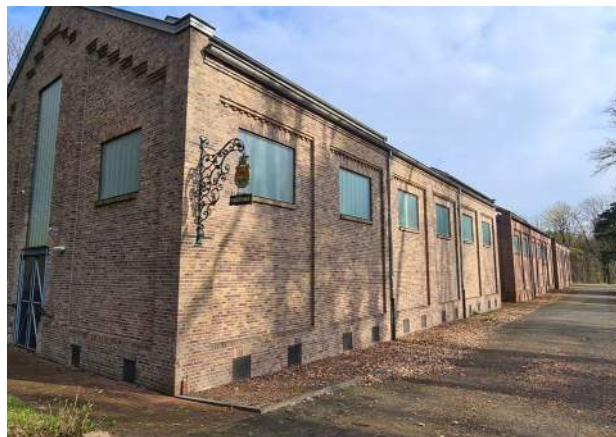
De gerestaureerde pompgebouwen liggen op een centrale locatie in het Schutterspark.
