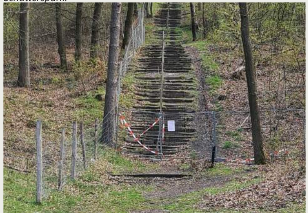
De trap vormt een belangrijke verbindende zichtlijn binnen het Schutterspark en is dringend toe aan groot onderhoud/renovatie.
