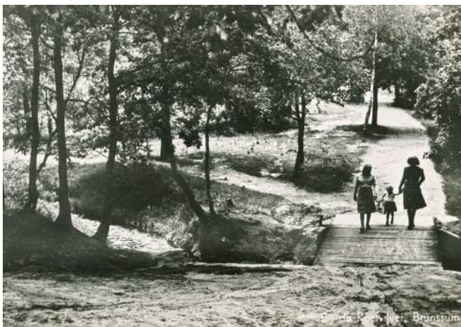
De vernieuwde padenstructuur noordelijk van de roeivijver langs de Roode beek.
