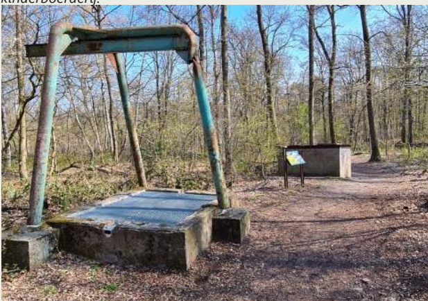
De voormalige pompputten zijn dringend toe aan conservering, zodat ze hun kenmerkende uitstraling ook voor toekomstige generaties behouden.
