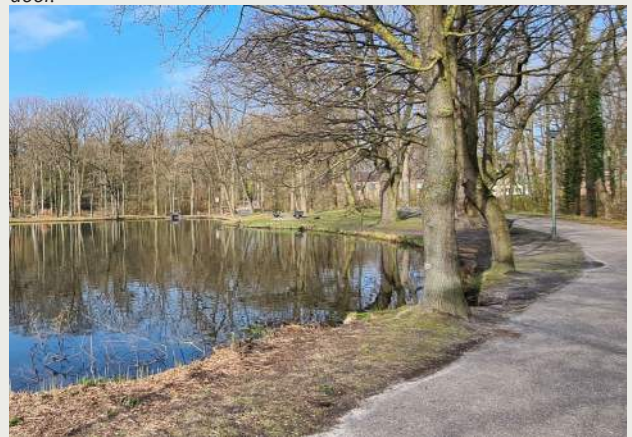
De oeverbeschoeiingen van de roeivijver en de kleine vijver zijn toe aan groot onderhoud.
