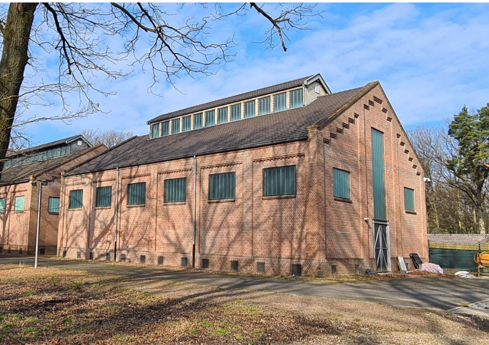
De gerestaureerde pompgebouwen (eigenlijk filtergebouwen/ontijzeringsgebouwen).
