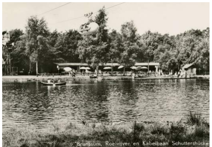
De roeivijver met links het dalstation van de kabelbaan en centraal de overkapt kiosk met terras.
