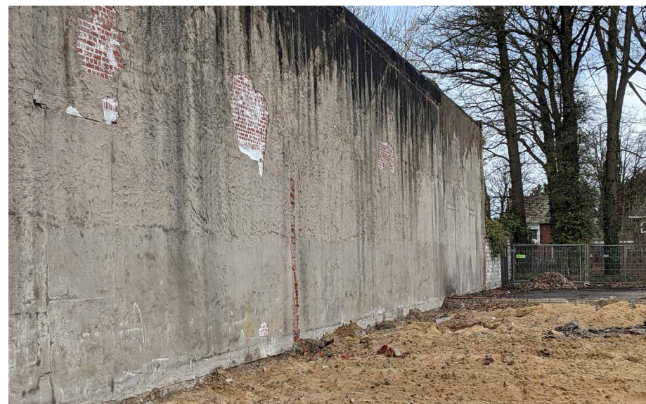
Westzijde van de muur in huidige situatie
