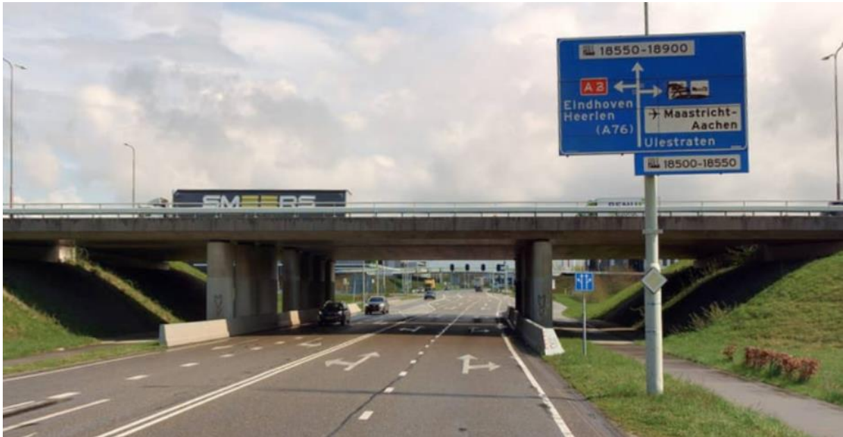
Voor viaduct A2
