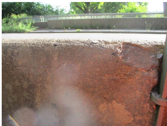
Foto 31 Betonschade borstwering
