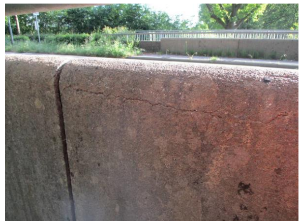
Foto 30 Scheur borstwering
