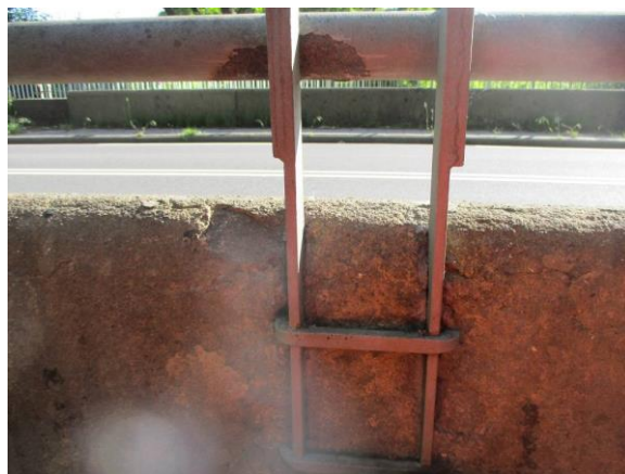
Foto 32 Betonschade borstwering
