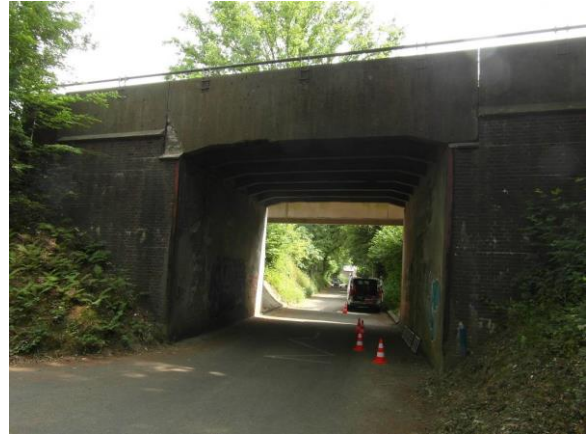
Foto 2. Westelijk aanzicht viaduct
