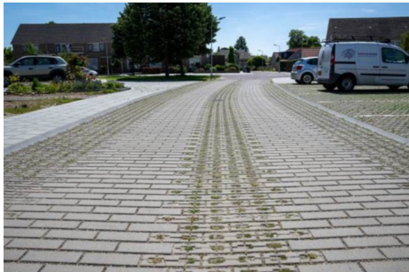
Voorzien van lichtgrijze klinker bestrating in halfsteensverband afgewisseld met open bestrating in karrespoor.
