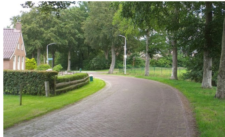
Bestrating opsluiten met halfsteens banden, geen opsluitbanden
