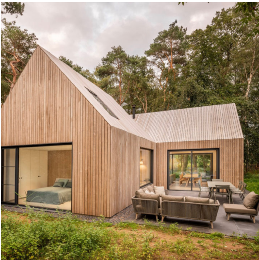
Gekapte bouwvolumes uitvoeren met verholen goot
