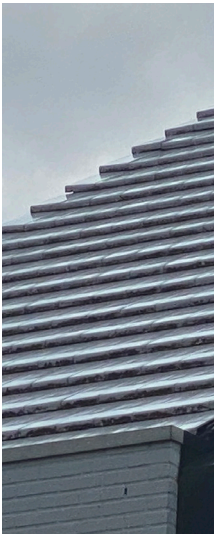
Pannendak mogelijk in kleur van gevel
