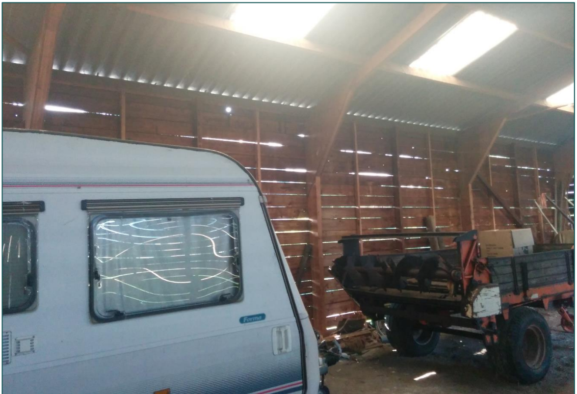
Figuur 6 Binnenzijde van de grote schuur.
