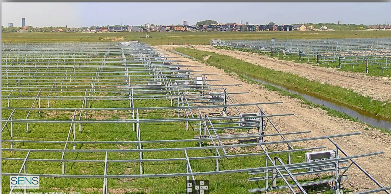
Livestream tijdens het bouwproces zonnepark Drachtsterweg in Leeuwarden
