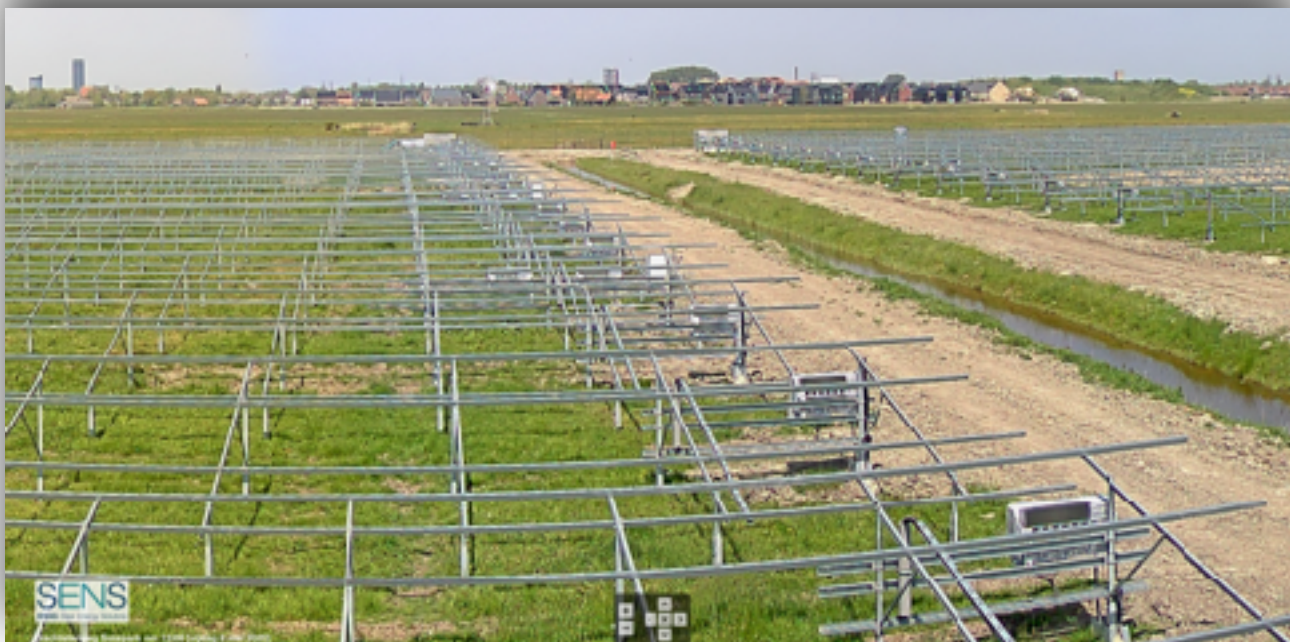
Livestream tijdens het bouwproces zonnepark Drachsterweg in Leeuwarden
