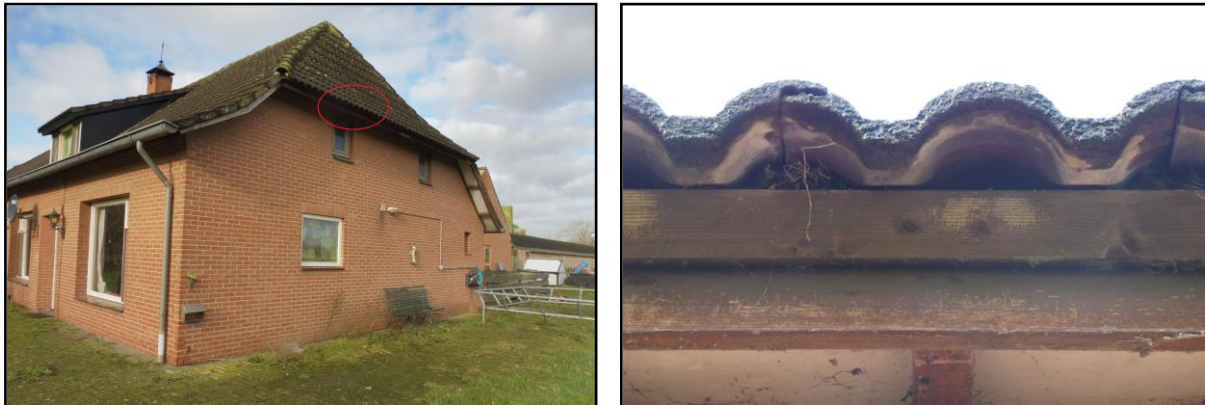
Figuur 3. Aangetroffen huismussennesten in de te slopen bedrijfswoning.
