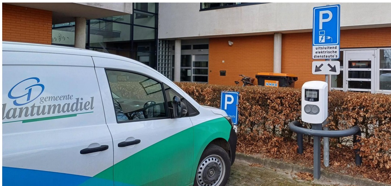
Figuur 2: Laadinfrastructuur bij gemeentehuis voor het opladen van elektrische bedrijfswagens.
