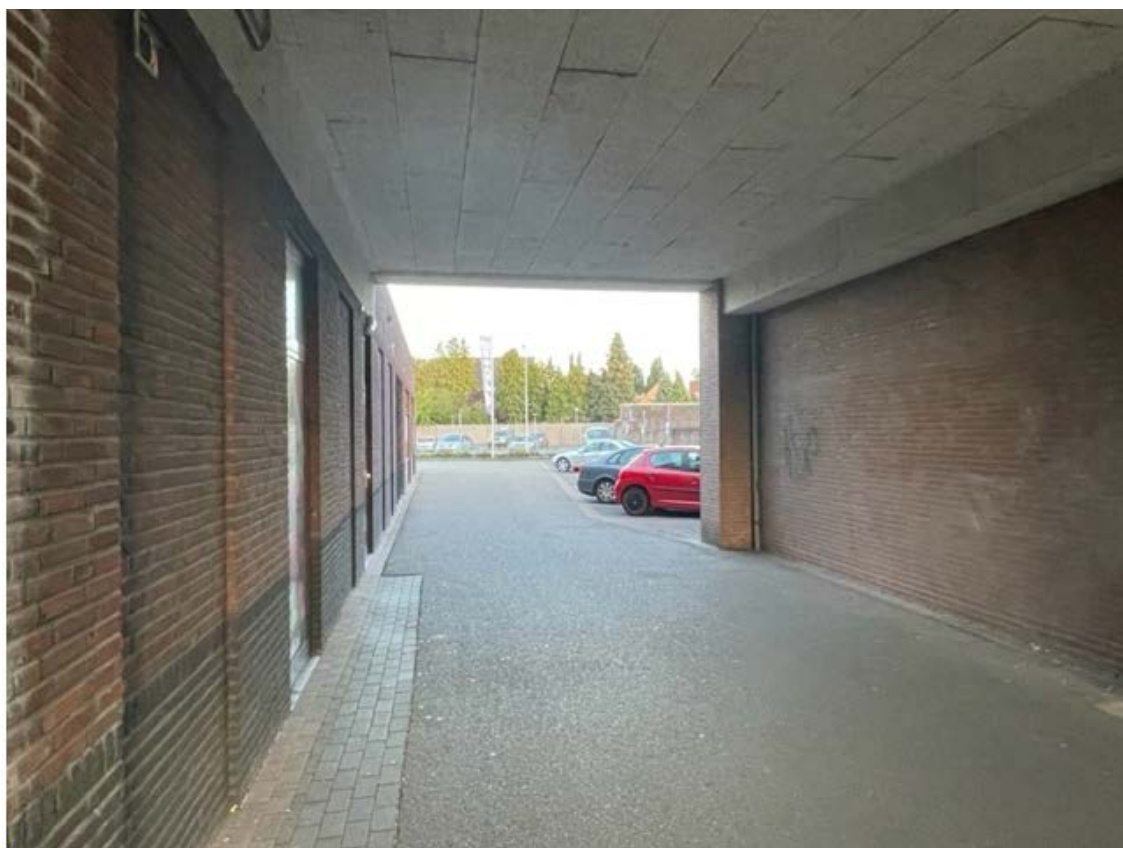
Figuur 2.8 Bestaande onderdoorgang richting zuidelijk parkeerterrein
