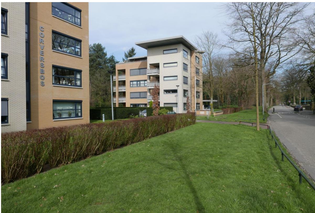
Hogere bebouwing aan de Schuttersweg
