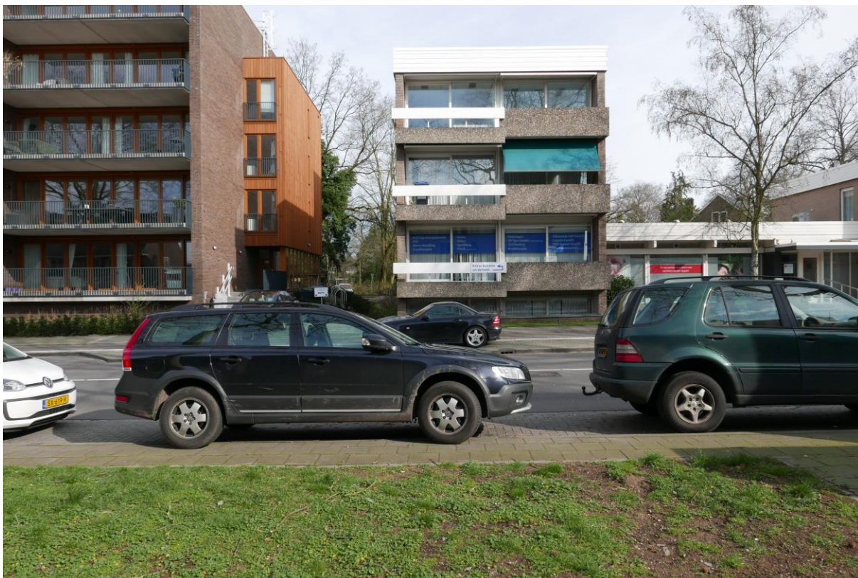
Overgang tussen Vaartweg 182 en 180
