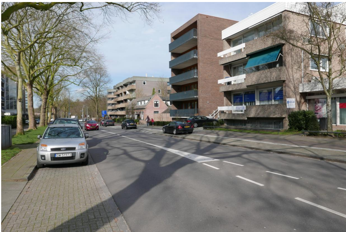
Vaartweg 180 en aangrenzende hogere nieuwbouw Vaartweg 182
