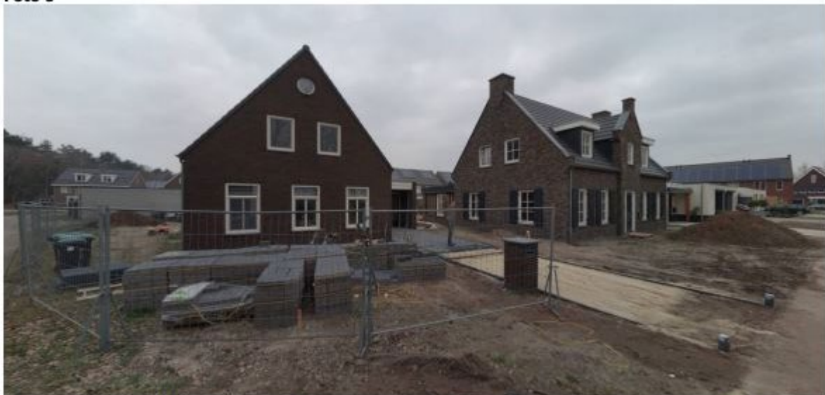
Foto 1 / 8 maart 2021 van het in aanbouw zijnde deelgebied 2. Gefotografeerd vanuit hoek Plaggen / bos. Op de achtergrond de gerealiseerde woningen uit deelgebied 1.
