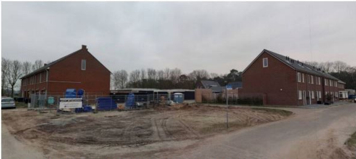
Foto 2/ 8 maart 2021 van het in aanbouw zijnde deelgebied 2. Gefotografeerd vanuit hoek Bultpad / Peelseheide.
