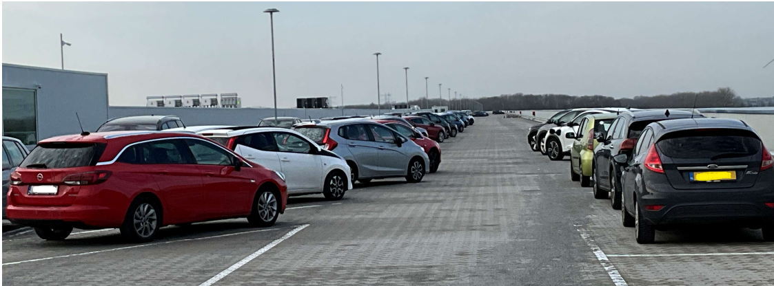
Parkeerplaatsen op dak logistiekgebouw.
