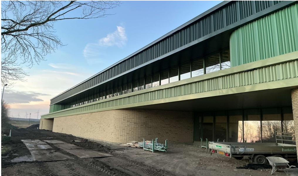
Sporthal in aanbouw.
