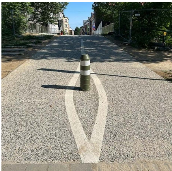
Figuur 9: Voorbeeld overrijdbare paal op brug Gent
