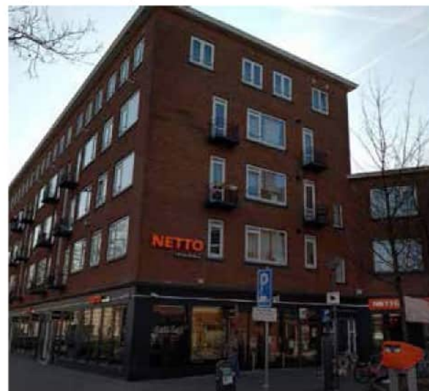
Diverse voorzieningen op de hoek Pleinweg en Ebenhaëzerstraat
