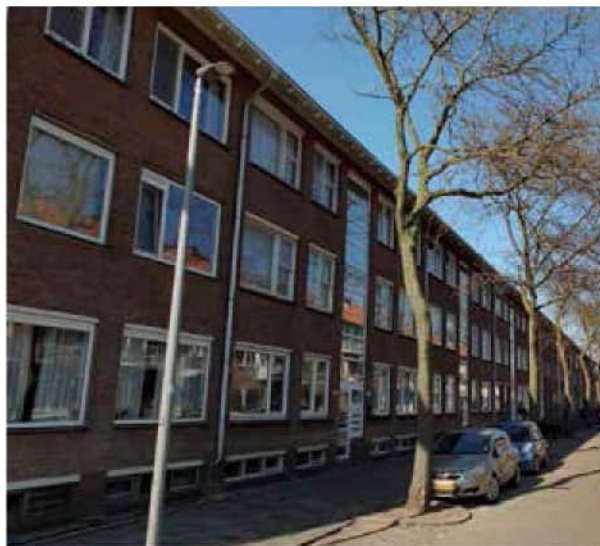
Eenzijdige woningvoorraad, Vogelbuurt
