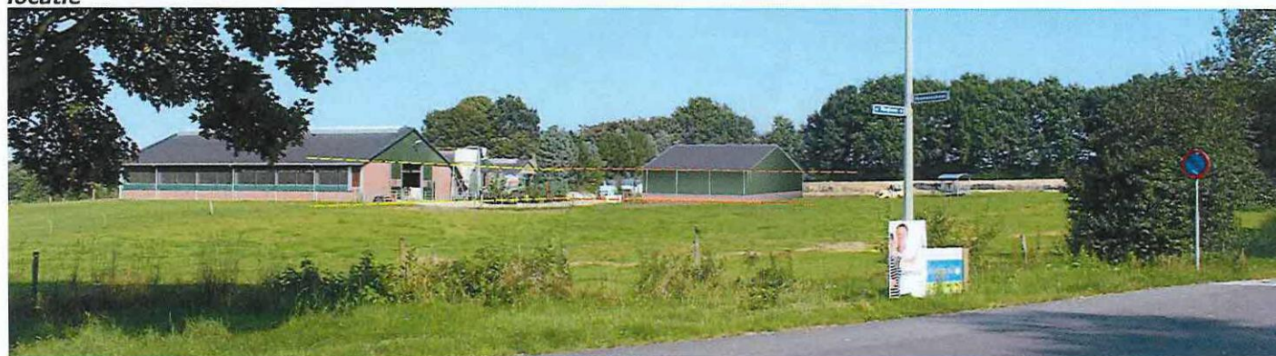
montage van de loods
