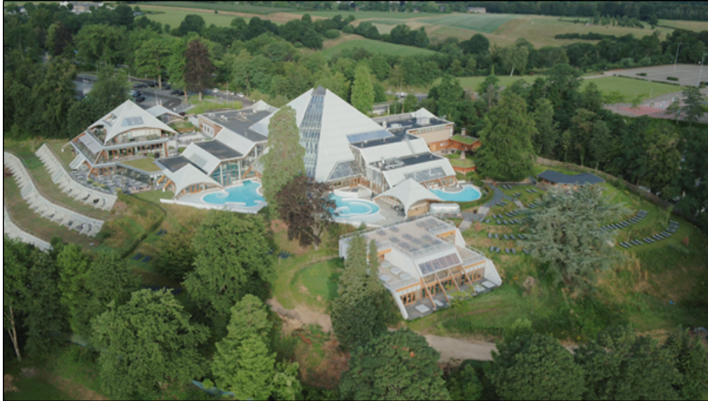
Foto's bestaande situatie
