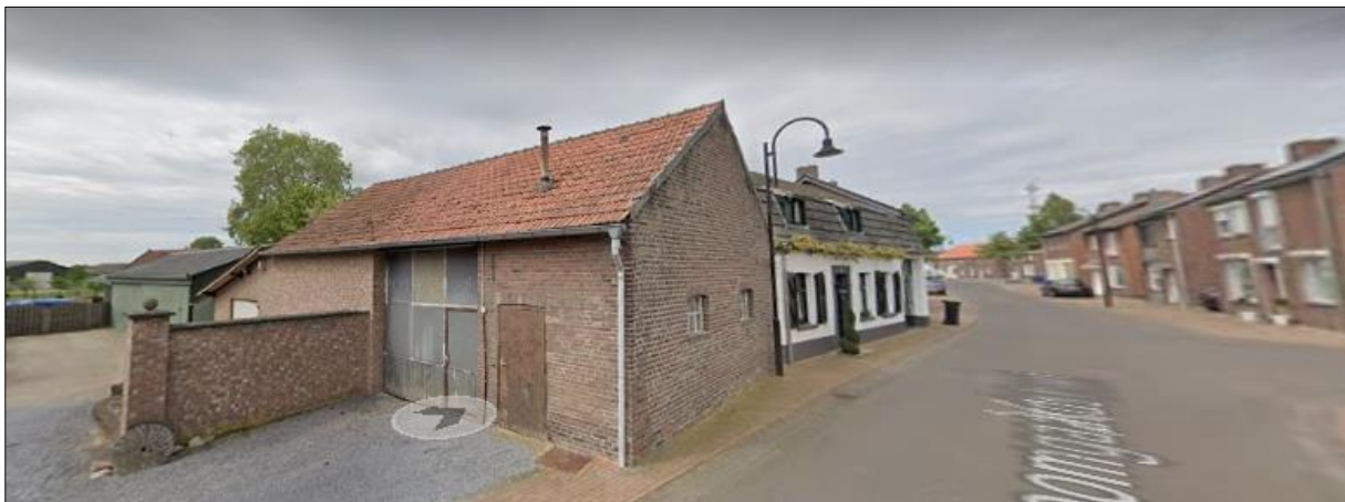
Afbeelding 12: Voorzijde plangebied te slopen schuur
