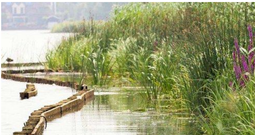
Figuur 9: Natuurvriendelijke oever met vooroeverbeschoeiing die plaatselijk onderbroken is.
