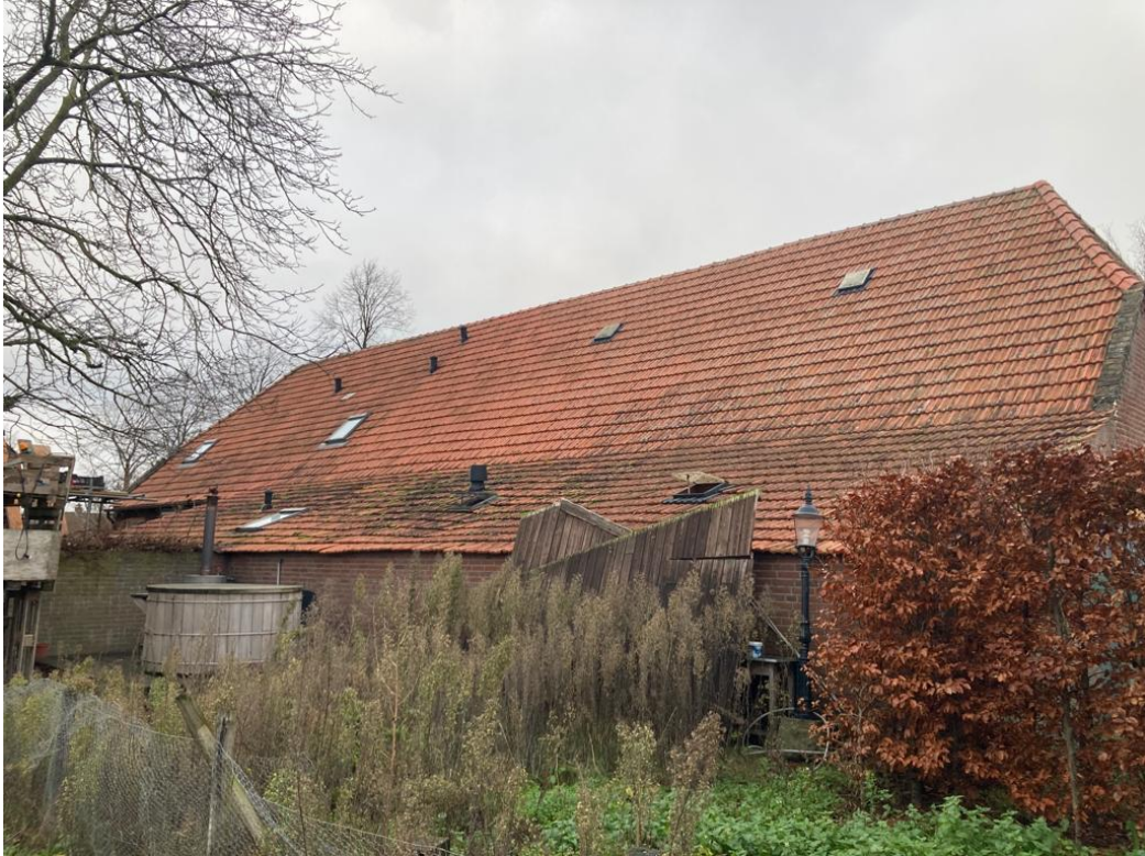
• Afbeelding 16: achterzijde woonhuis
