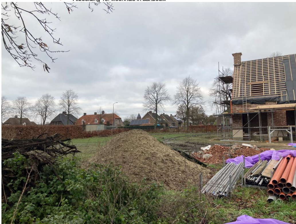
• Afbeelding 15: woonhuis in aanbouw
