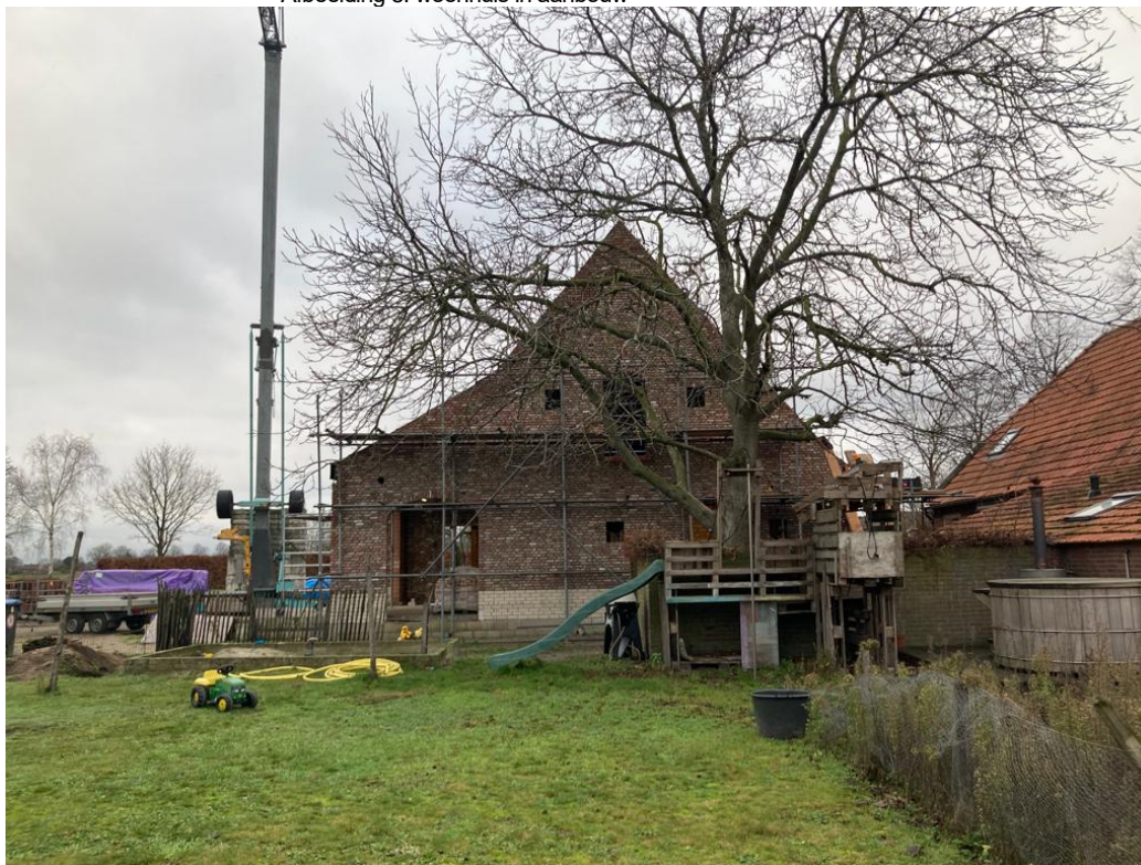
• Afbeelding 8: woonhuis in aanbouw
