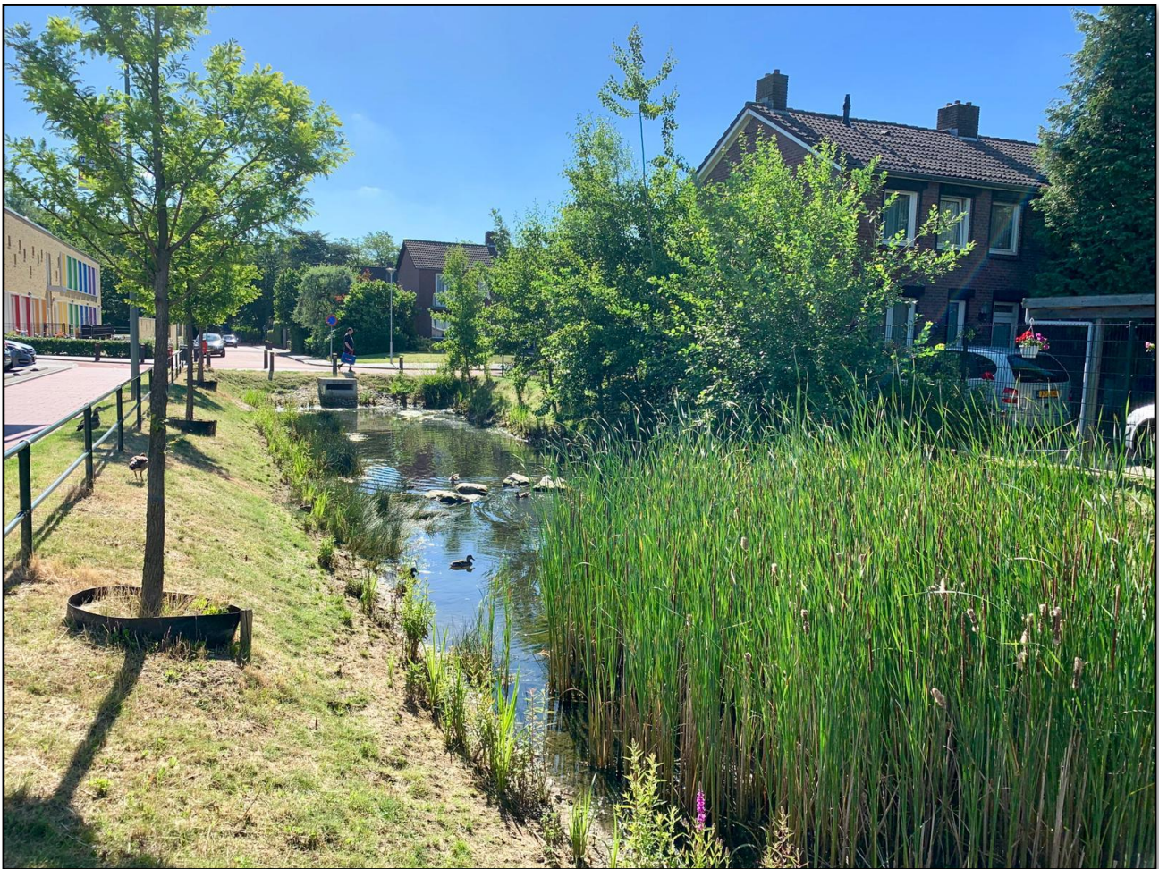
Figuur 4. Bergingsvijver in de gemeente Brunssum welke geknepen naar het oppervlaktewater afvoert.
