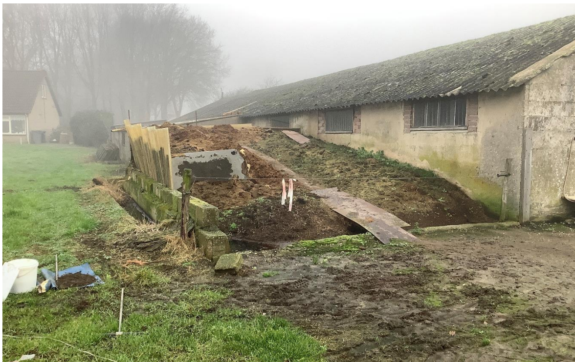
Foto van de onderzoekslocatie, nabij boring 111 – d.d. 16 december 2021
