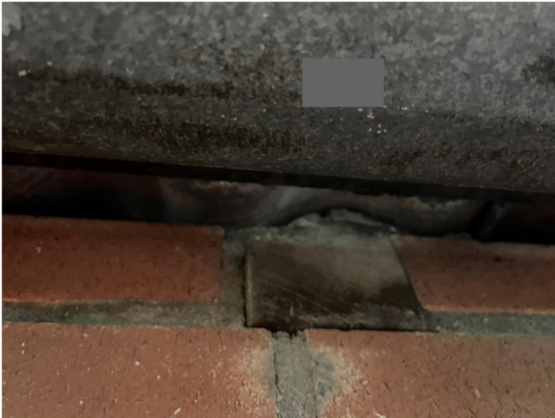
Foto 14: het dak van de zuidelijke schuur is gecementeerd met de oorspronkelijke muur.
