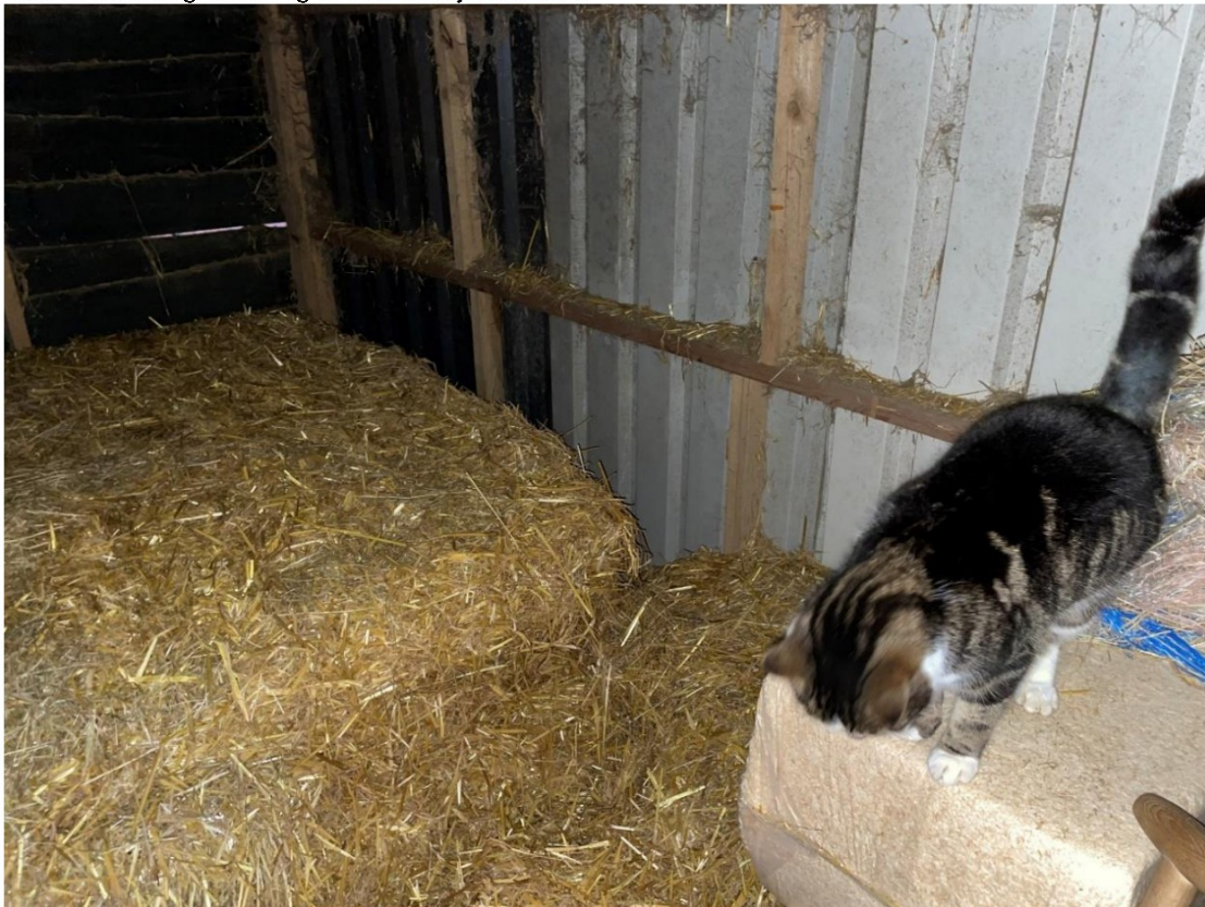
Foto 9: de aangebouwde hooischuur bestaat uit een houten frame afgewerkt met metalen profielplaten en gepotdekselde planken. Deze wordt bewaakt door de kat.
