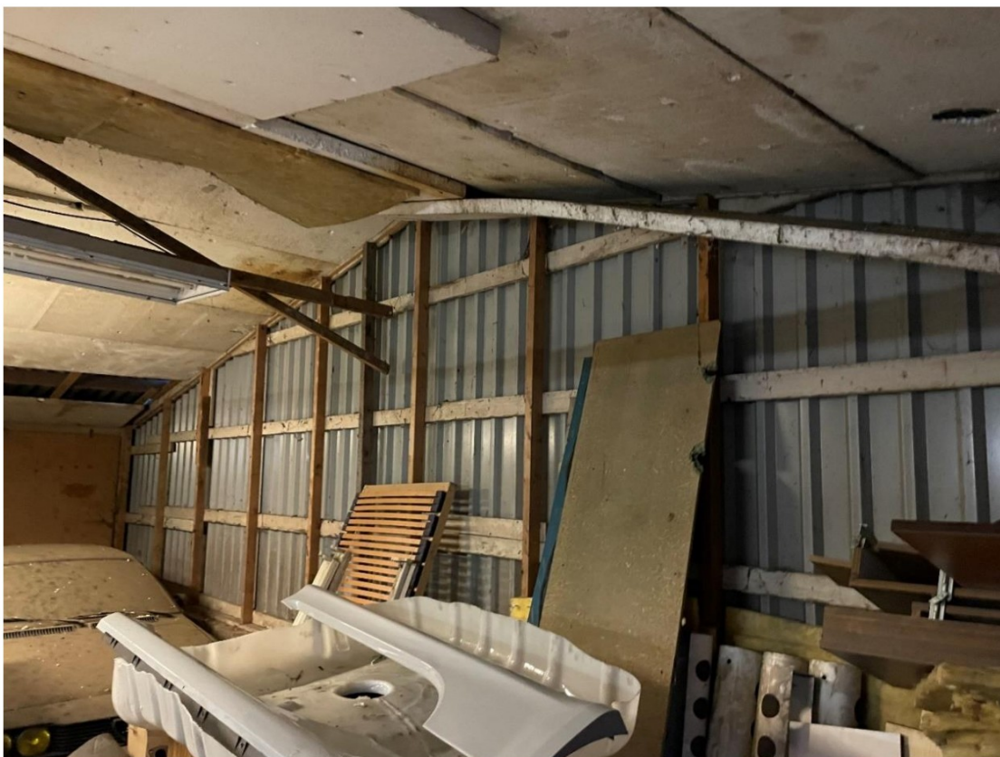
Foto 12: de binnenkant van de zuidelijke gevel. Zoals te zien bestaat deze gevel uit een houten frame met hierop metalen profielplaten.
