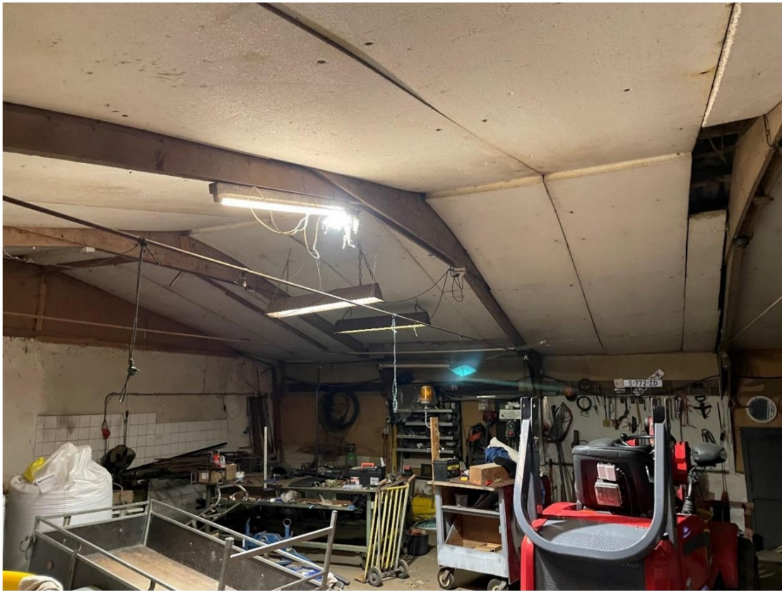
Foto 8: werktuigenstalling in de zuidelijke schuur.
