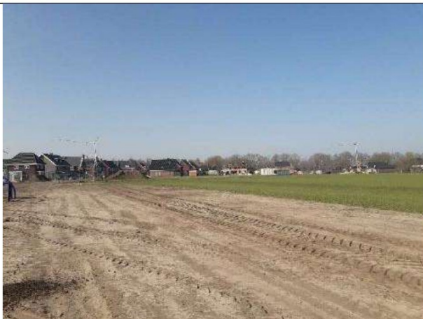
Foto 5: Overzichtsfoto boring 48 west
