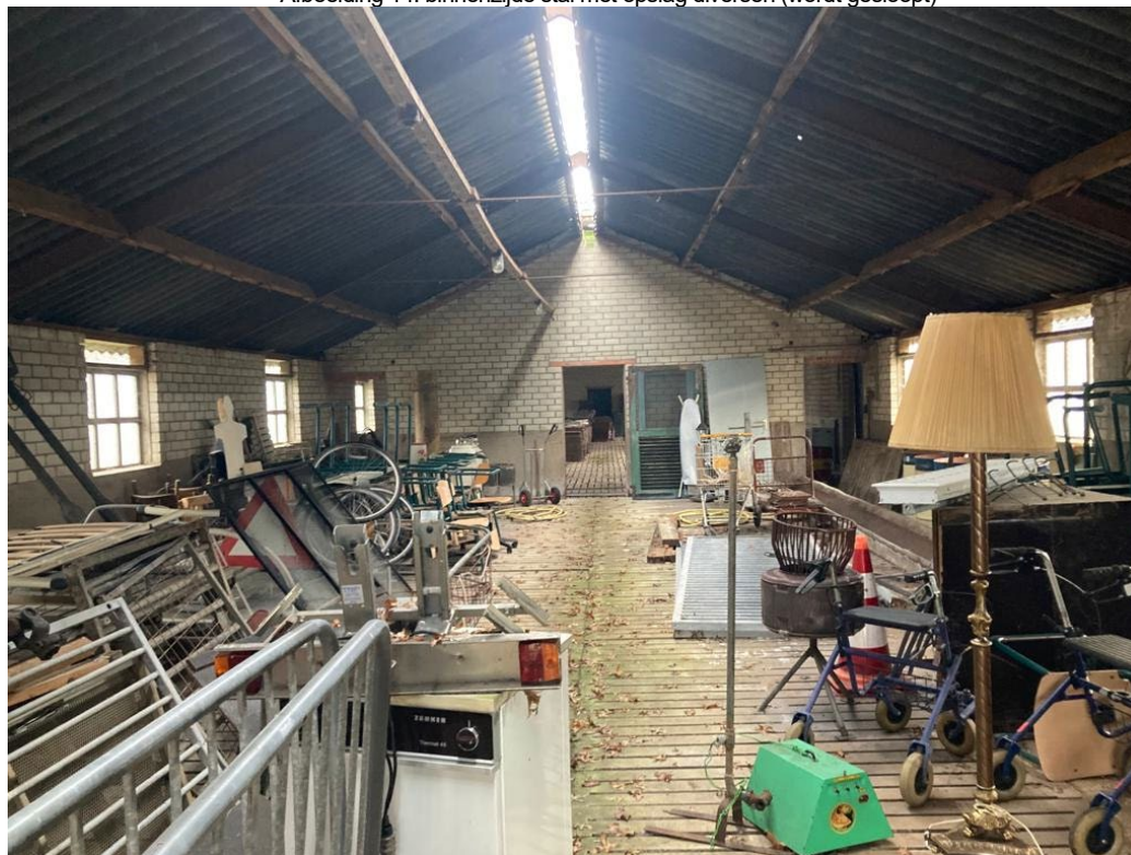
• Afbeelding 14: binnenzijde stal met opslag diversen (wordt gesloopt)
