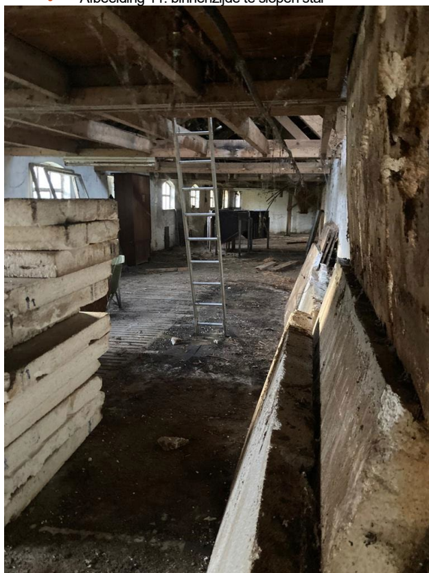
• Afbeelding 11: binnenzijde te slopen stal
