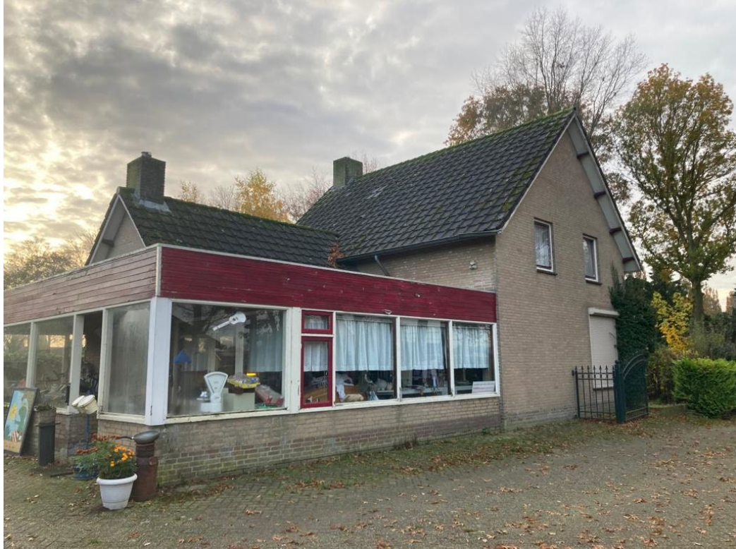
• Afbeelding 24: woonhuis achterzijde
