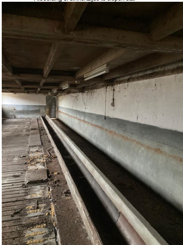
• Afbeelding 6: binnenzijde te slopen stal
