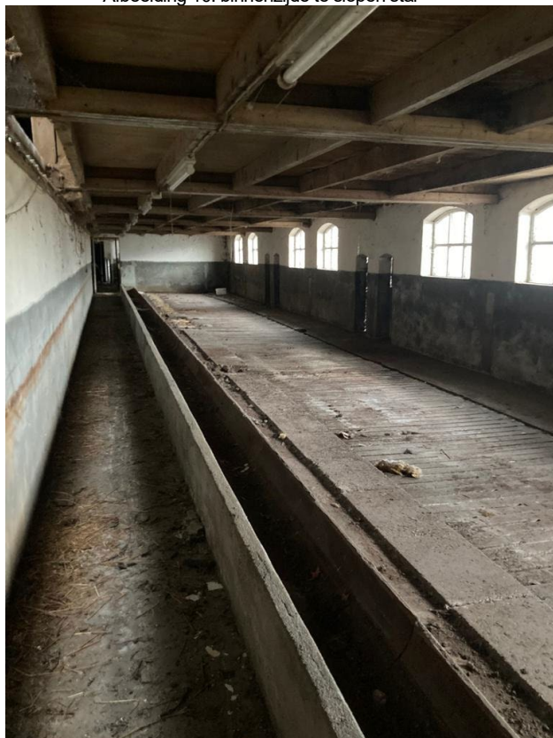
• Afbeelding 10: binnenzijde te slopen stal
