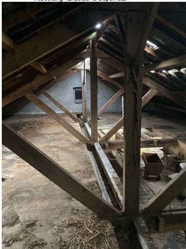
• Afbeelding 12: zolder te slopen stal
