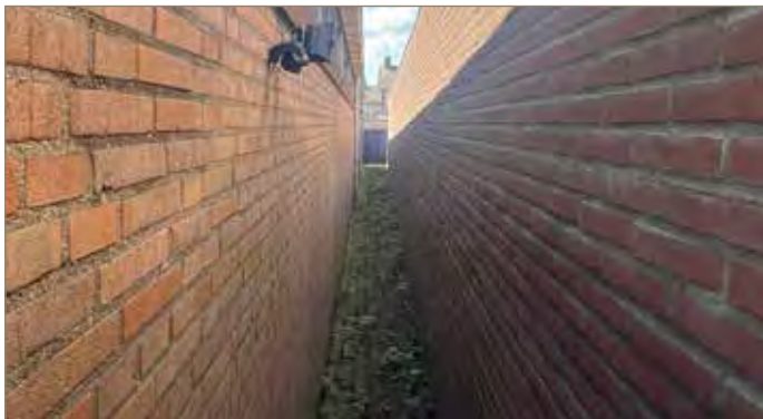
Ruimte tussen bedrijfsloods en garageboxen
