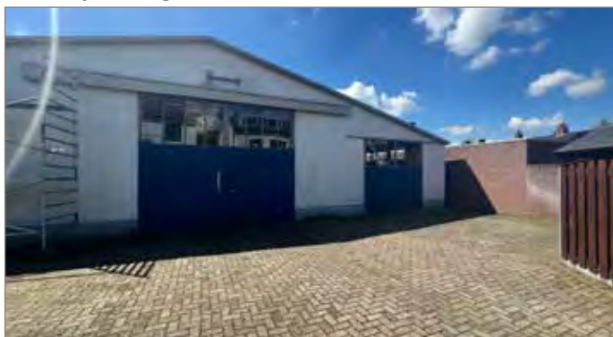
De bedrijfsloods (leegstaand)
