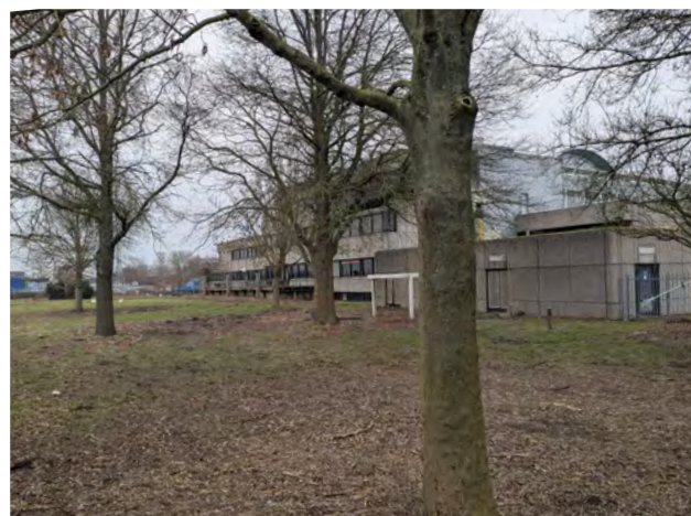
De locatie gezien vanaf de zuidwest zijde.; op de voorgrond te behouden bomen en op de achtergrond gebouwen die gesloopt worden.
