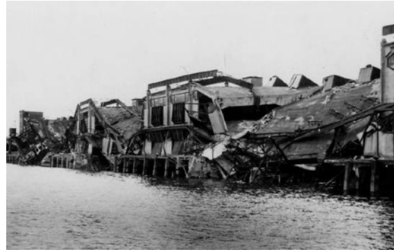
De Fenixloodsen en de Provimi loods vormen van oorsprong één geheel
