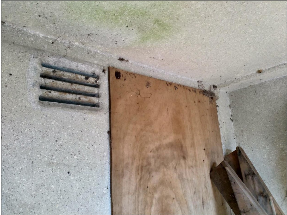
Binnen de bebouwing van het plangebied zijn geen plekken waar gebouwbewonende vleermuizen zich kunnen herbergen. Er zijn geen kieren aanwezig.
