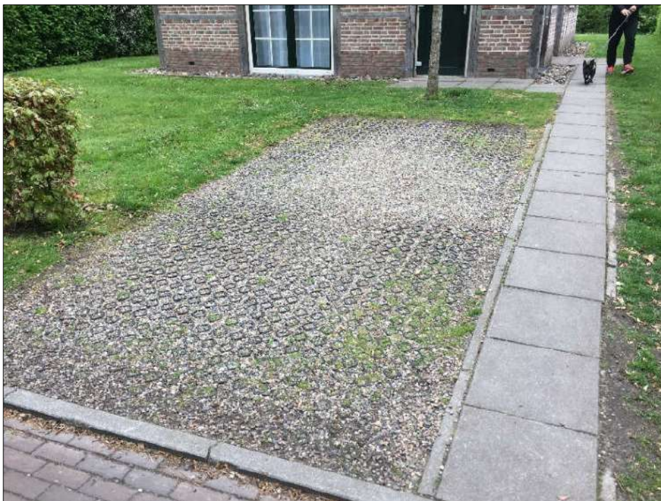
Afbeelding 17: Voorbeeld drukverdelende fundering;
