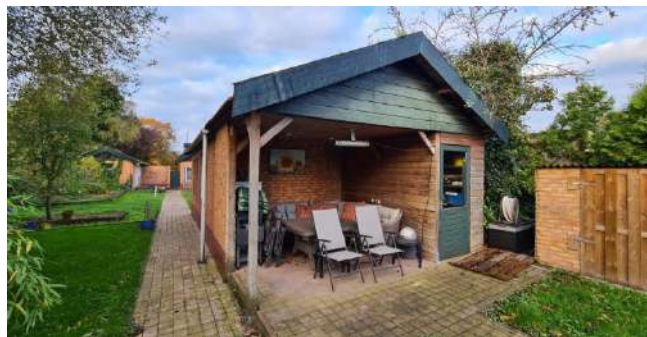
Figuur 8: Bijgebouw in het oosten van het plangebied
