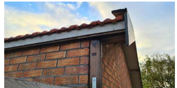
Figuur 9: Dakrand bijgebouwen
