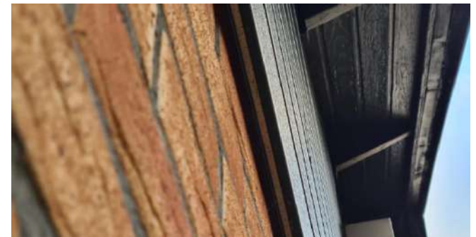
Figuur 6: Detailopname gevelbetimmering en dakrand
