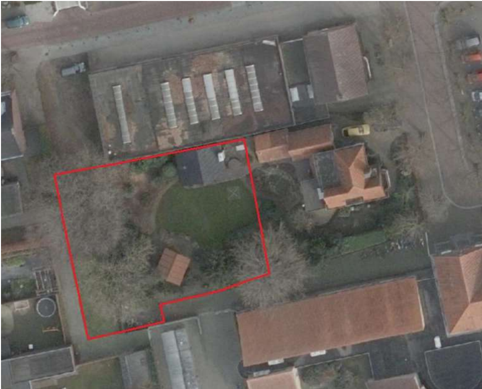
Bestaande inrichting plangebied, rechts de huidige woning, links de tuin waar de twee-onder-een-kapwoning gerealiseerd zal worden
