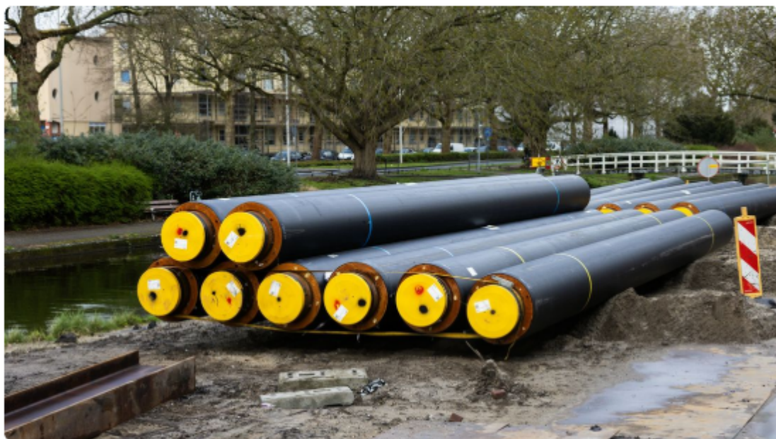
Buizen voor een warmtenetwerk liggen klaar om de grond in te gaan © ANP / Laurens van Putten
