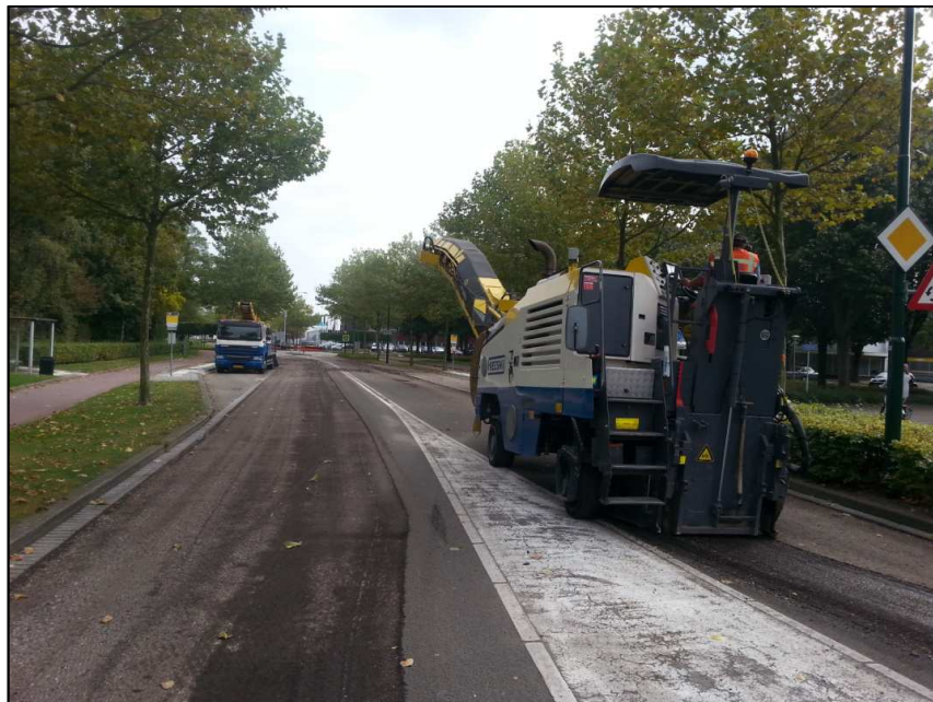
Asfaltreparatie vervangen toplaag
