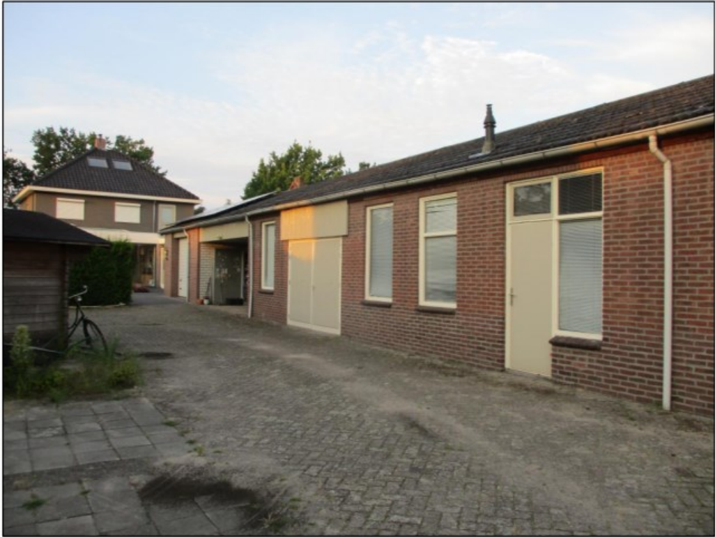
Figuur 3 Autogarage C zal gesaneerd worden.
