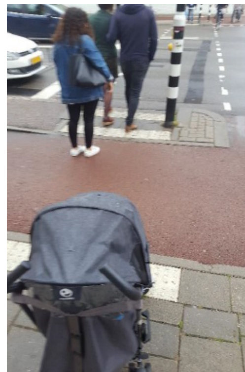
Foto 2: beperkte opstelruimte voetgangers t.h.v. ASW 423
