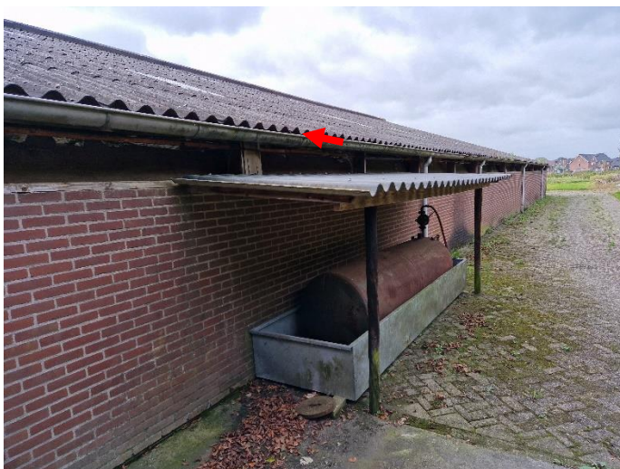
Figuur 19 De voormalige koeienstal van Bloemendaallaan 77 heeft openingen, onder andere ter hoogte van dakgoot en is daarmee toegankelijk voor huismus; dit gebouw wordt mogelijk gebruikt als nest- en rustplaats
