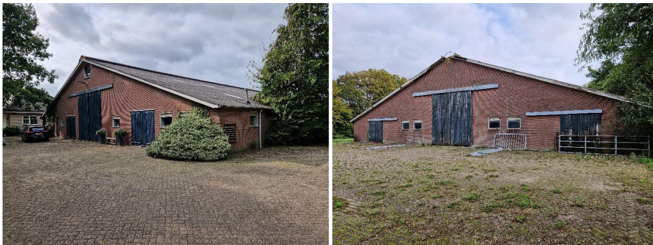
Figuur 48 Foto-impressie plangebied. Figuur links: Voorzijde voormalige koeienstal van Bloemendaallaan 77. Figuur rechts: Achterzijde voormalige koeienstal van Bloemendaallaan 77
