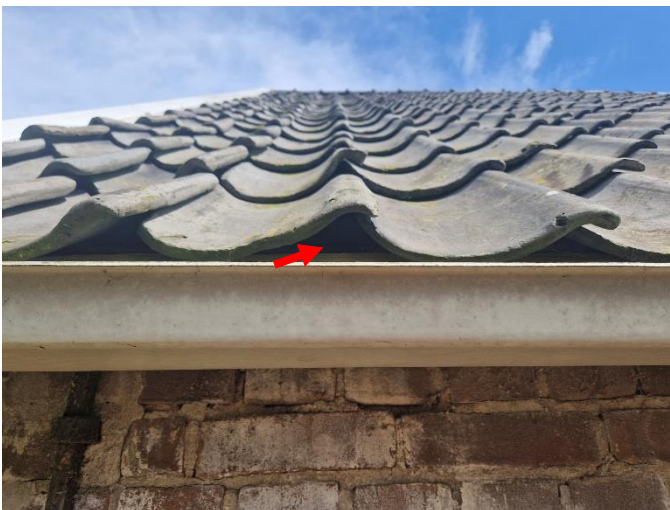
Figuur 17 De schuur van Nijkerkerweg 128 heeft openingen, onder andere ter hoogte van dakgoot (zie rode pijl) en is daarmee toegankelijk voor huismus; dit gebouw wordt mogelijk gebruikt als nest- en rustplaats
