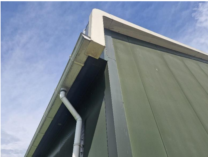
Figuur 33 De loods van Nijkerkerweg 126-1 heeft een metalen behuizing waar geen openingen aanwezig; het is voor vleermuizen niet mogelijk om via de buitenschil in de constructie te verblijven
