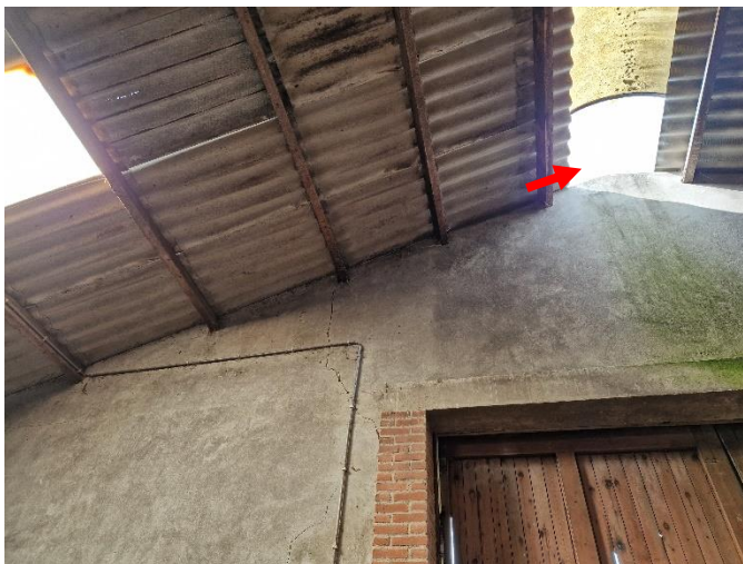
Figuur 11 Door de opening in het dak (zie rode pijl) van de voormalige koeienstal van Bloemendaallaan 77 kunnen steenuil en kerkuil binnenkomen
