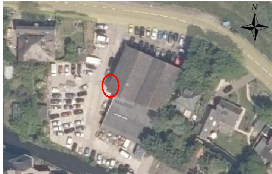
De potentie voor verblijfplaatsen van vleermuizen bevindt zich enkel aan de westzijde van de bebouwing (zie rode cirkel).
