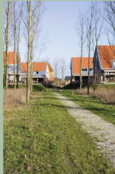
Verandawoningen - Almere - Onix NL
