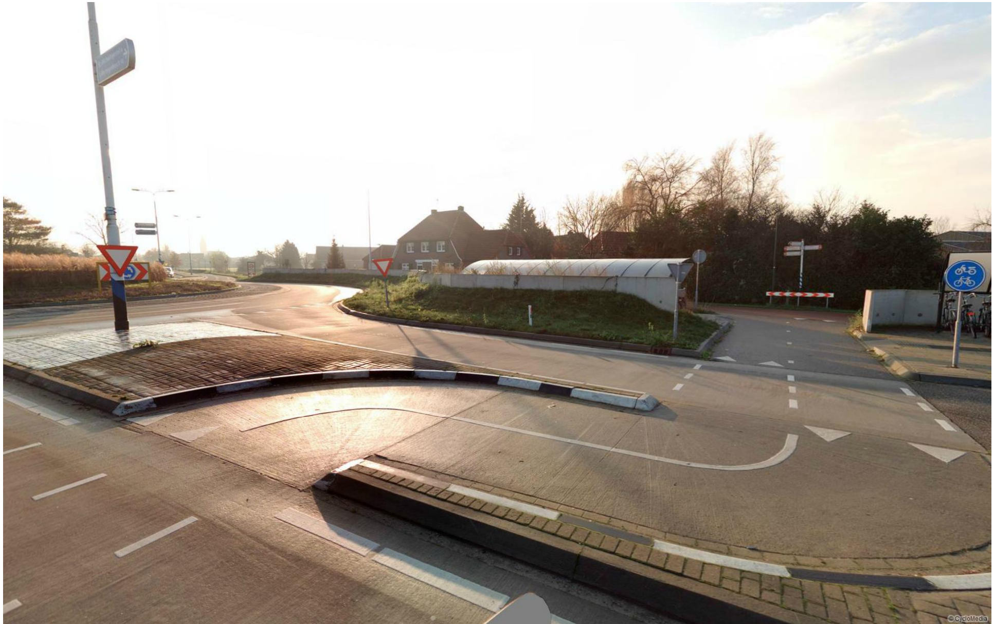
N617 bebouwde kom Schijndel
